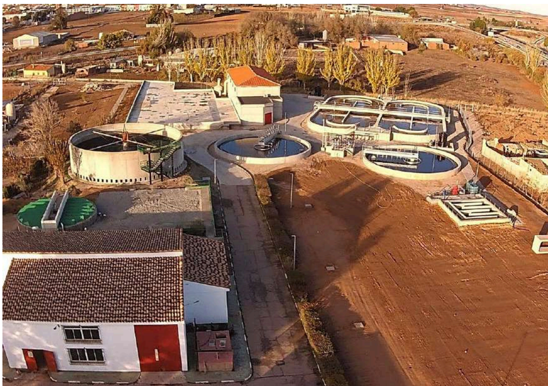
Depuradora de Madridejos (Toledo) ABC
