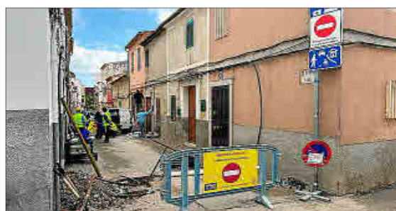
La calle Nou es una de las afectadas por las obras.
